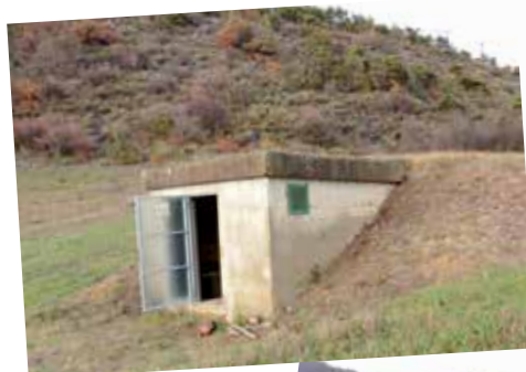
RÉSERVOIR DES MALCORPS
