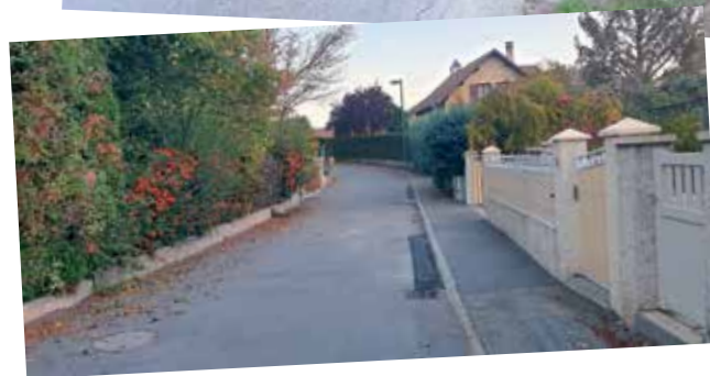
GOUDRON ET RÉSEAU PLUVIAL, LOT. PRE VESCAL
